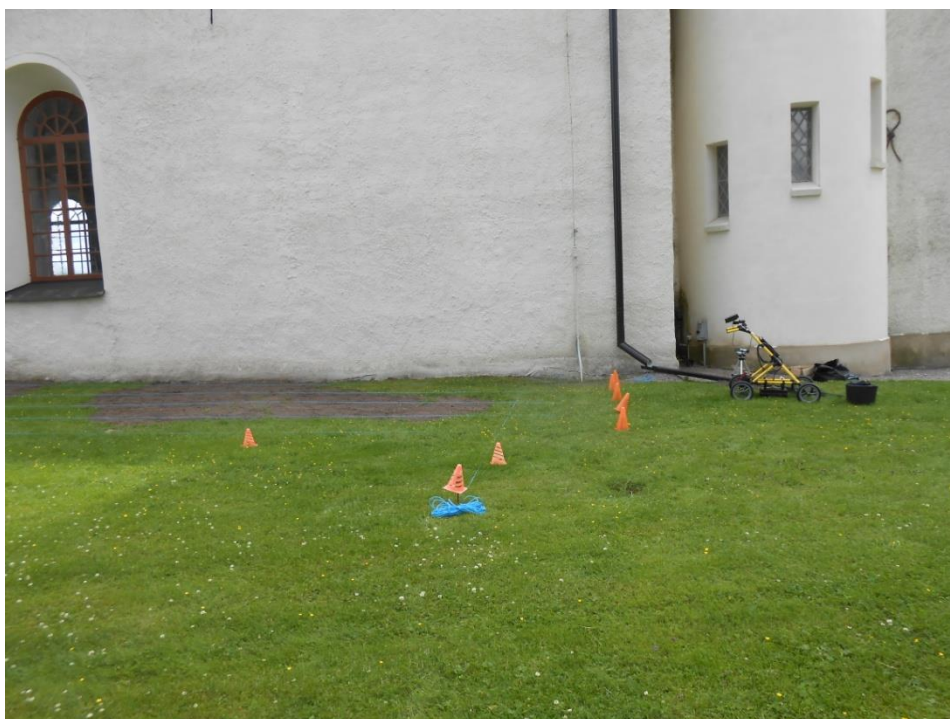
Fig.15. Södra långsidans gräns mot tornet.
