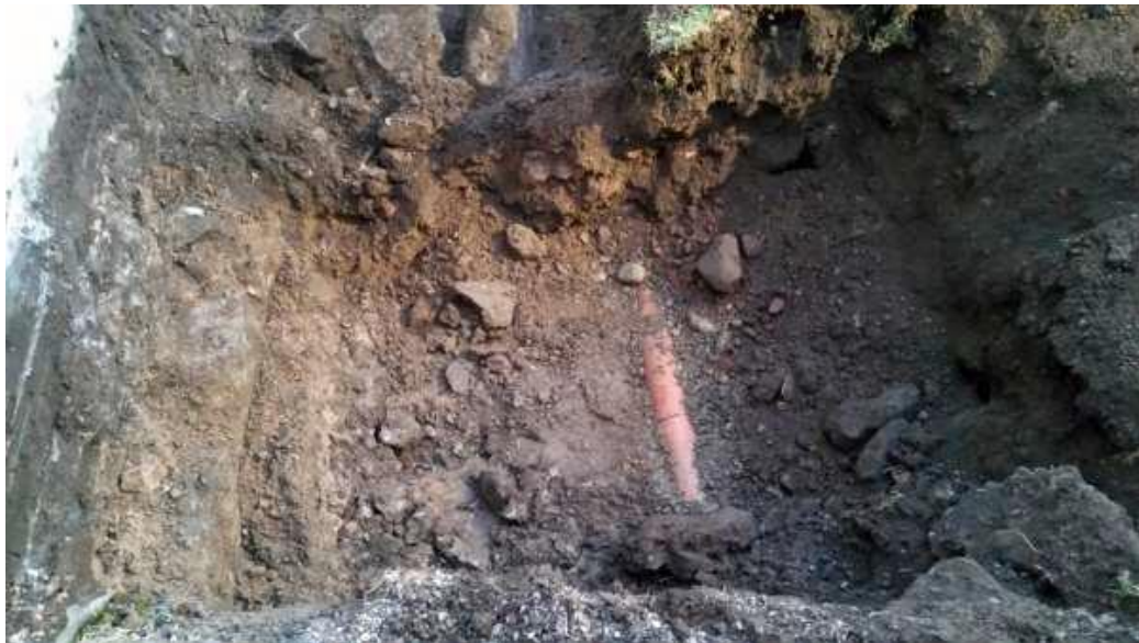
Fig. 12. Detta är dräneringsledningen i figur 10. Bilden är hämtad från rapport 2015:11, länsstyrelsen i Södermanlands län.
